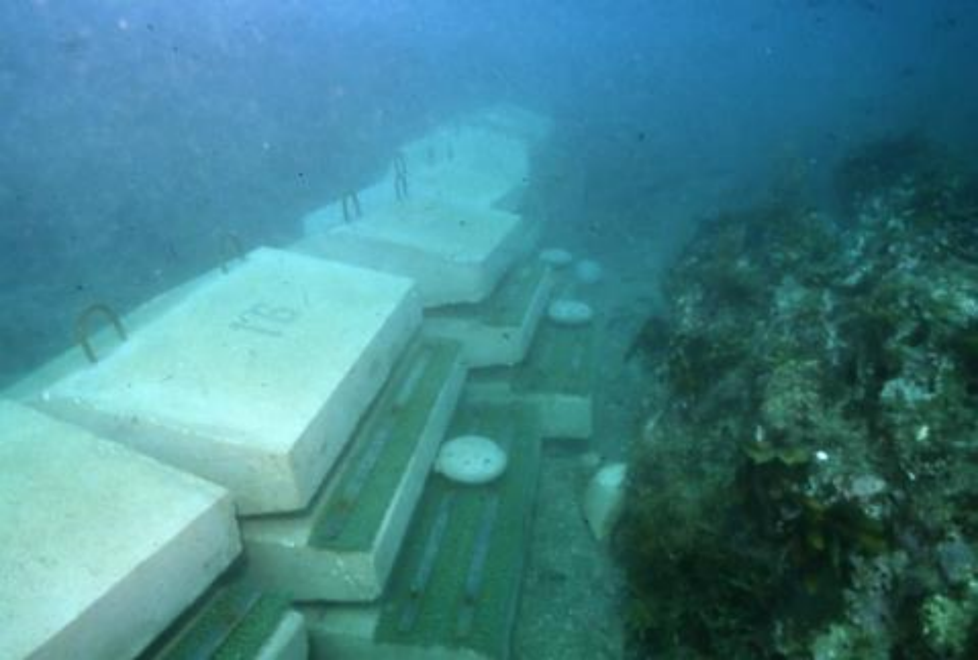
手結地先に設置した試験礁
