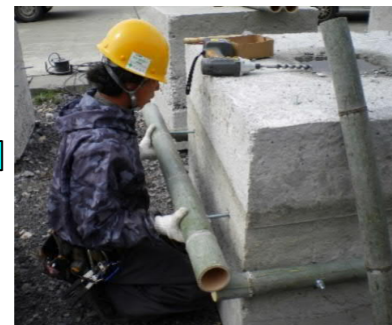
ブロックに巻き付け
