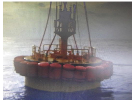
浮体を吊出し投入
