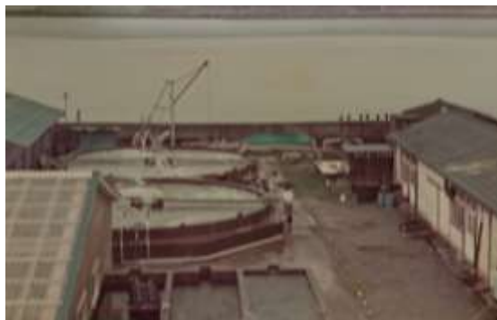
旧徳島県水産試験場鳴門分場施設
